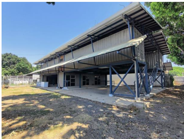
Foto: aulas construidas con proyecto del ICD, ubicadas en CAI 26 de Julio.
